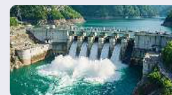
水力発電所 ダム、水路 など
