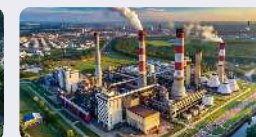
火力発電所 取放水路・港湾 など
