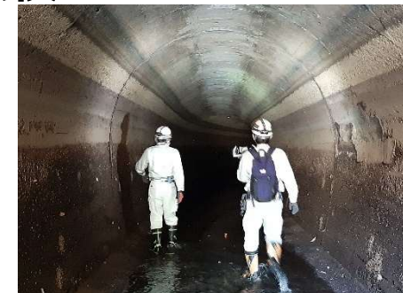
点検員による 水路内点検
