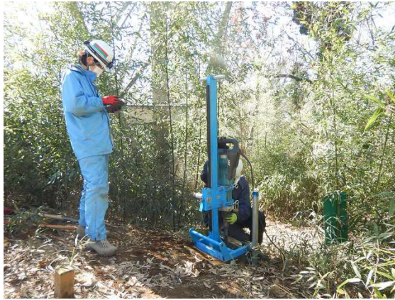
斜面での振動貫入試験
