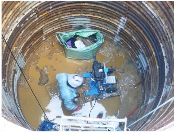
深礎面の振動貫入試験機による床付け検査
