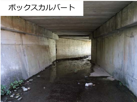
小河川の橋梁
