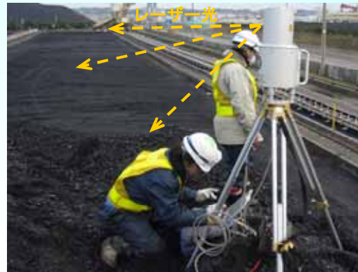
現地作業状況 (貯炭山山頂から)
