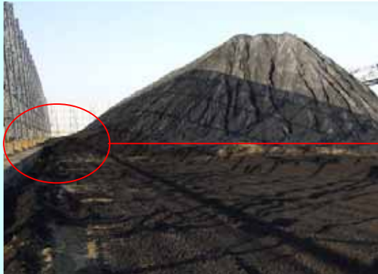
急峻な貯炭山（斜面の筋は崩落跡）
