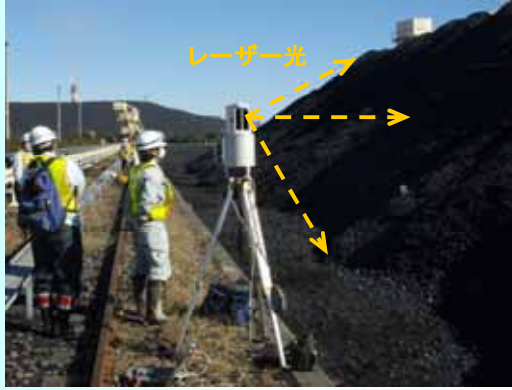
現地作業状況 (貯炭山山裾から)
