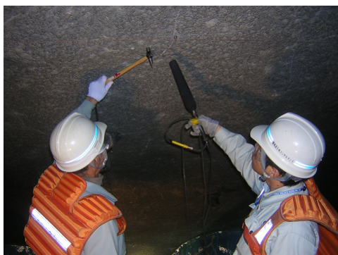
近接部 ハンマーによる打音調査
