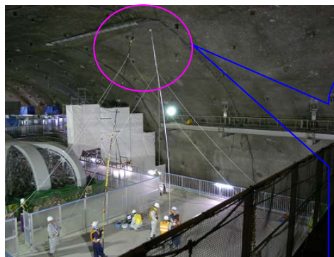
高所部 打撃ジグを使用した打音調査
