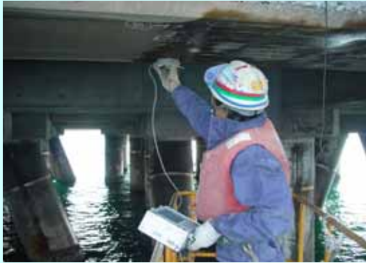
分極抵抗測定状況 (使用機器：四国総合研究所製)
