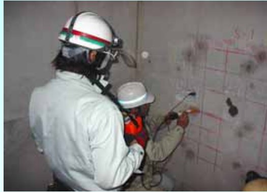
自然電位測定状況 (使用機器：エルコメーター製)
