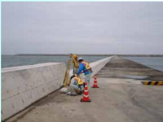
スタティック法 (静止測量) 測量状況
